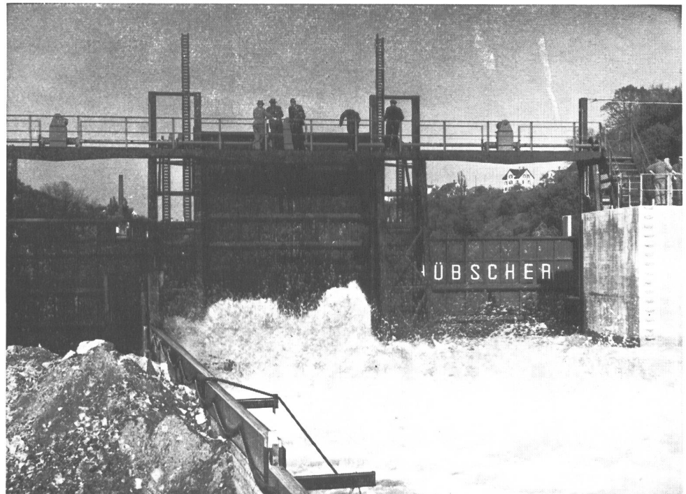
Hilfswehr: KW Schaffhausen
