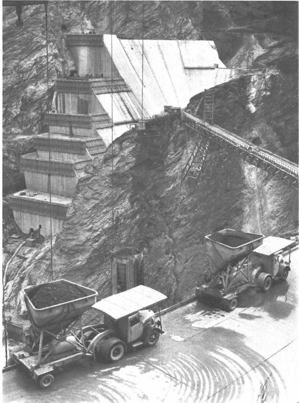
Staumauer Luzzone Bauzustand Juli 1961
