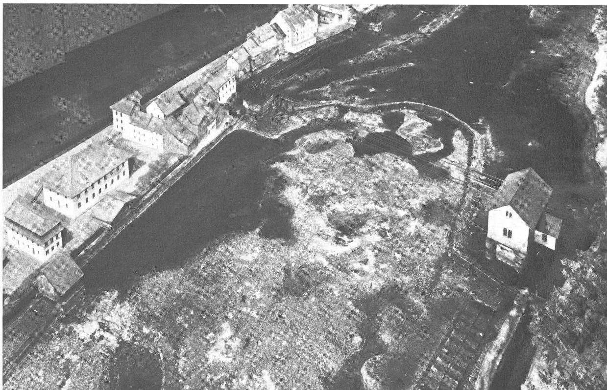
Bild 1 Modell des im Jahre 1866 in Betrieb genommenen Wasserkraftwerkes Schaffhausen mit dem «Moserdamm». Man beachte die mechanischen Transmissionen längs des rechten Rheinufer und besonders jene quer über den Rhein unterhalb des Moserdammes.
