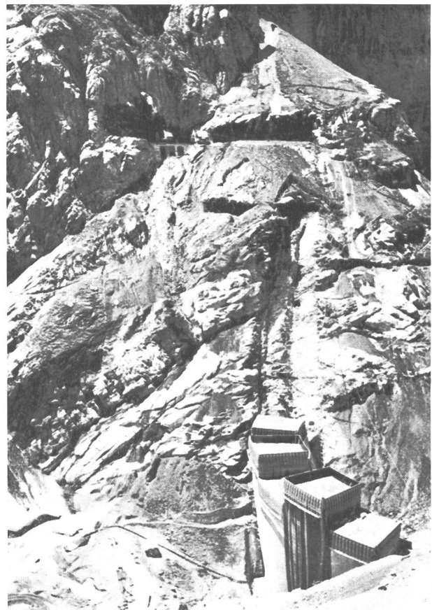
Bild 6 Widerlager-Aushub und Fundament der Bogenstaumauer Limmernboden; Zustand 15. Juni 1961 (vgl. Bild 6, S. 333 dieses Hefes)
