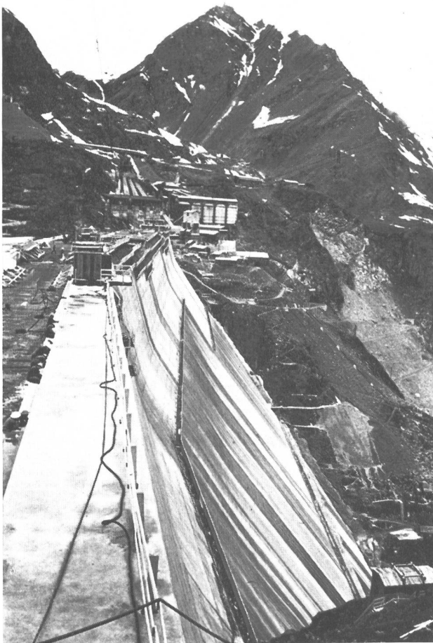
Bild 22 Staumauer Grande Dixence am 22. Juni 1961, kurz vor der Vollendung
