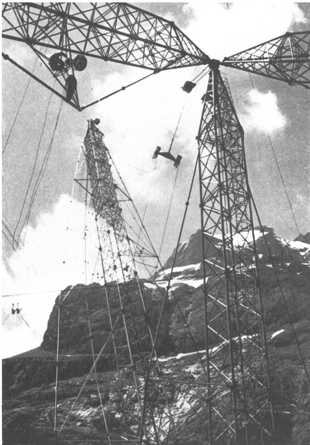
Bild 5 Großer Derrick-Kran für den Beton-Einbau der Staumauer Limmernboden
