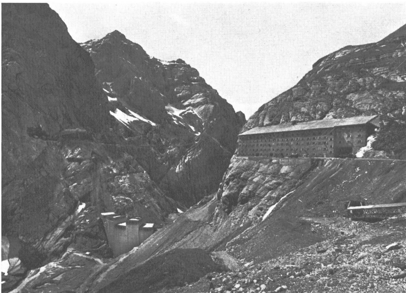
Bild 3 Baustelle und Berghaus Limmernboden; Aufnahme vom Juli 1961
