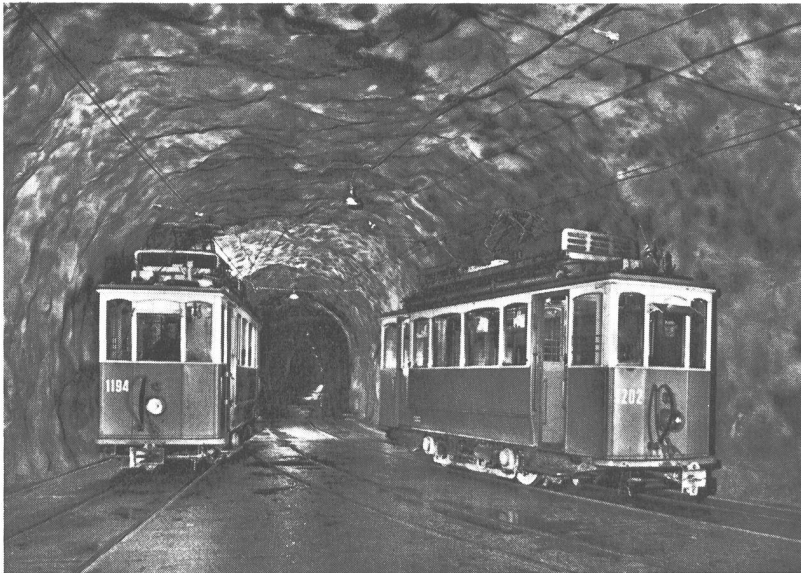
Bild 2 Im 2,9 km langen Zugangsstollen zum Limmernboden («Erste Versuchsstrecke der Zürcher U-Bahn»?)
