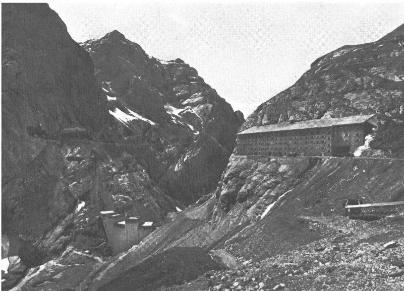
Bild 3 Baustelle und Berghaus Limmernboden; Aufnahme vom Juli 1961
