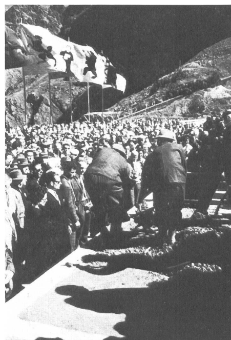
Bild 6 Einbringen des letzten Betons für die mehr als 6 Mio m 3 umfassende Staumauer Grande Dixence
