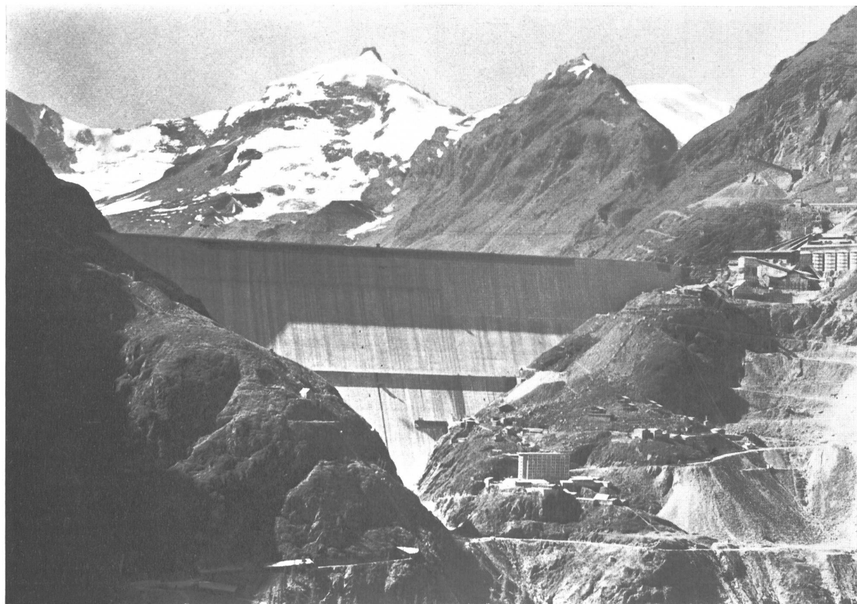
Eild 1 Die nach achtjähriger Betoniarbeit im September 1961 vollendete Gewichtsstauauer Grande Dixence im Kanton Wallis
