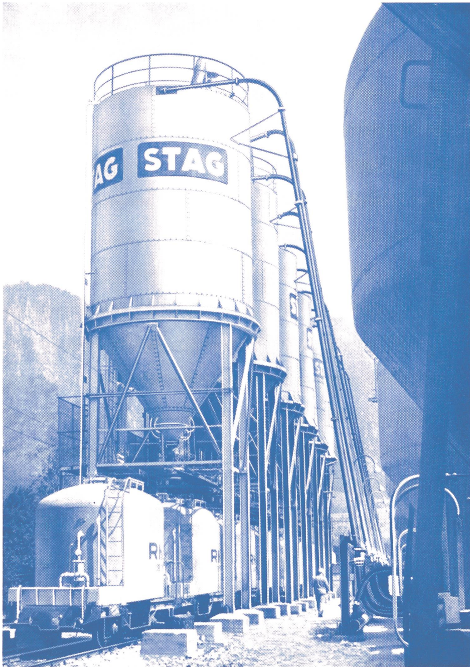
Umschlagsanlage der STAG in Landquart: 6 Silos à 200 t = Total 1200 t Fassungsvermögen Umschlag von SBB via Silos auf RhB-Bahnwagen
