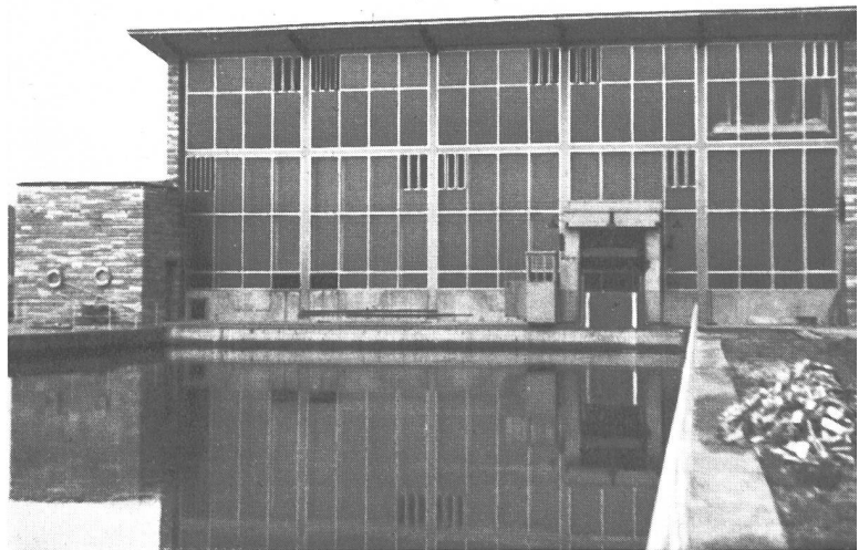
Bild 10 Maschinenhaus der Staustufe Poppenweiler; Glasfront gegen Osten mit Stahl und Aluminium; Schichtmauerwerk aus drei verschiedenen Steinarten
