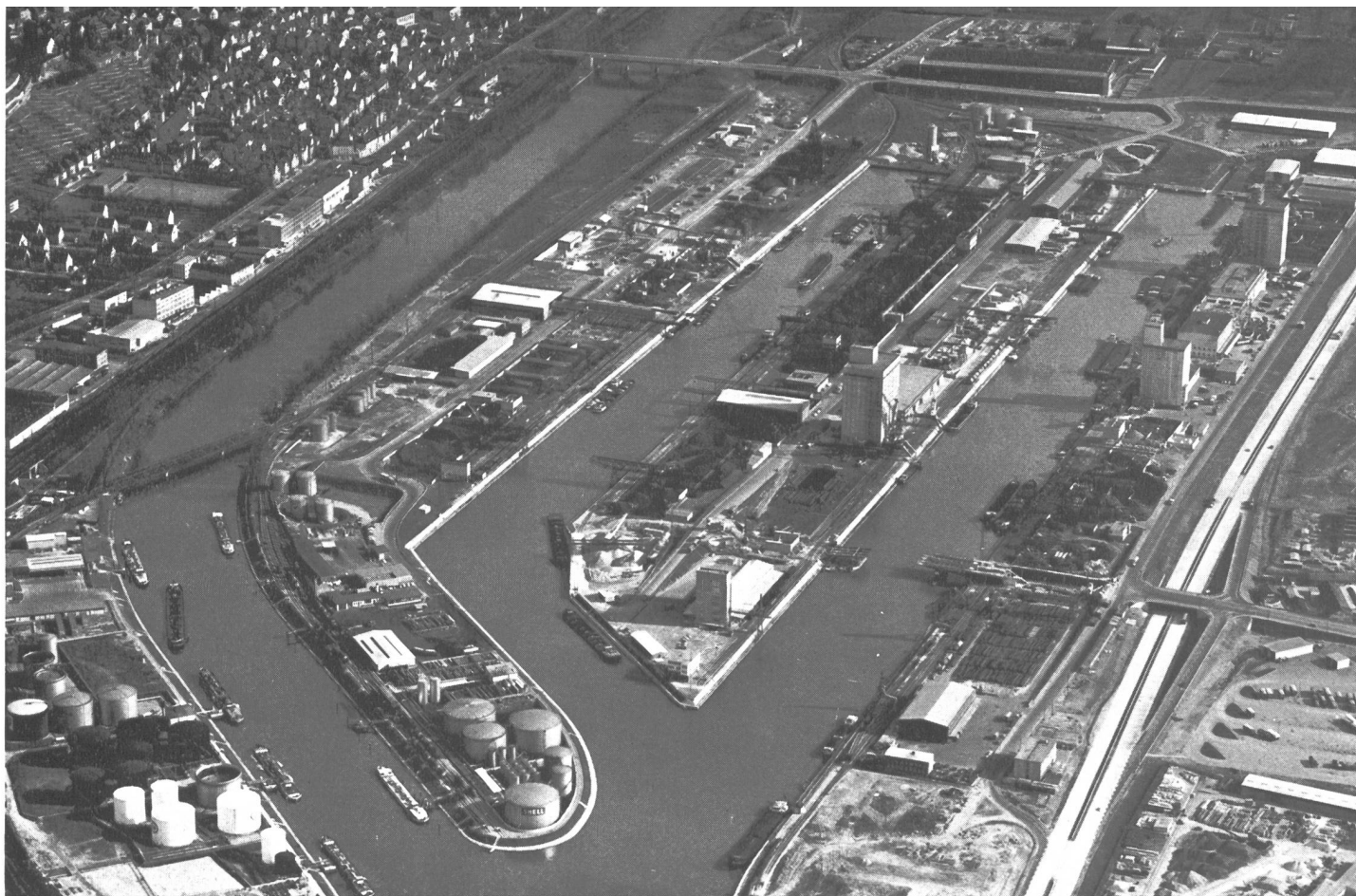
Bild 1 Luftaufnahme des Neckarhafens Stuttgart; links Neckar mit Ölhafen, Mitte Hafenbecken 2 mit Sicherheits- hafen und rechts Hafenbecken 1 (Luftbild freigegeben vom Innenministerium Baden/Württemberg Nr. 2/10881)
