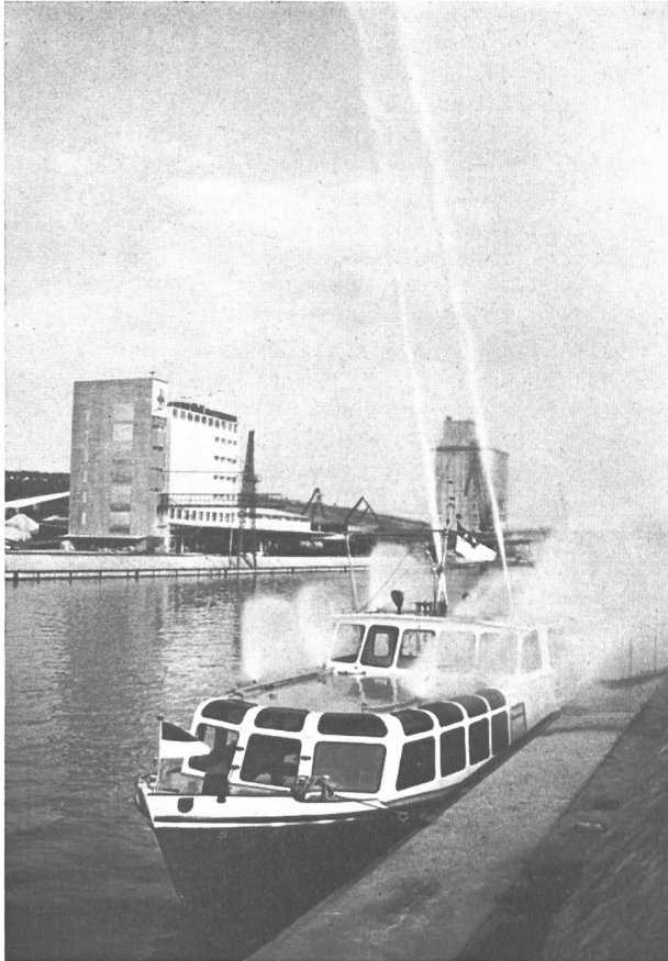
Bild 7 Das Motorboot der Hafenverwaltung demonstriert seine Fähigkeit als Feuerlöschboot
