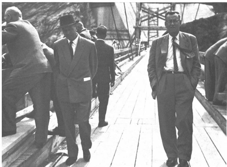
Bild 2 Exkursion zu den Blenio-Kraftwerken: SWV-Präsident Dr. K. Obrecht und Ing. H. Pfaff auf der Baubrücke Luzzzone
