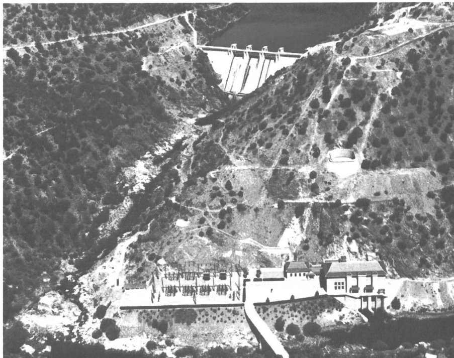
Fig. 23 Usine de Las Picadas
