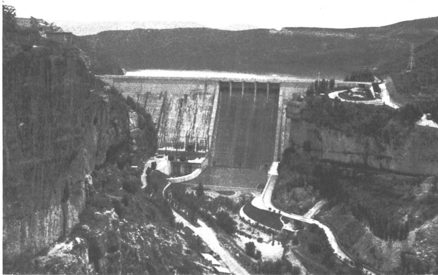
Bild 25 Blick auf die Gewichtstaumauer Entrepneñas in der Schlucht des oberen Tajo
