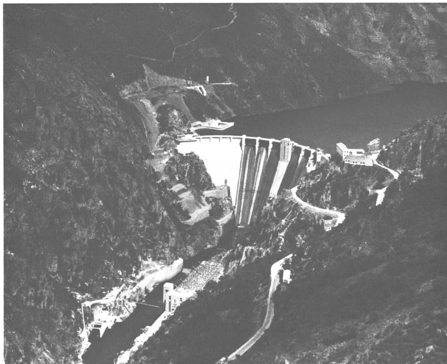
Fig. 43 Usine de San Esteban sur le Sil. Vue générale
