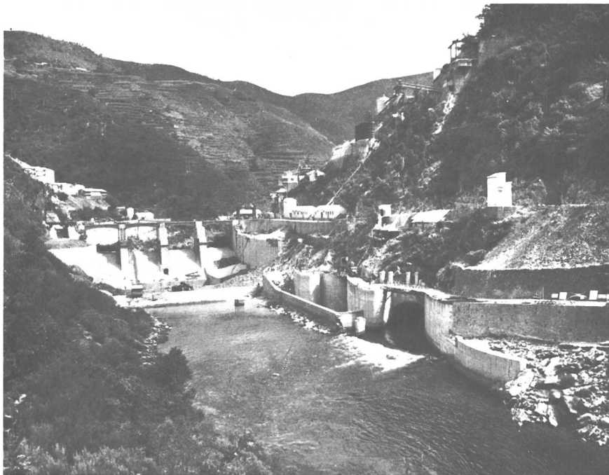
Fig. 44 Usine de San Pedro sur le Sil. Le barrage en cours de construction
