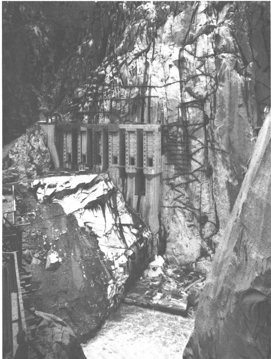
Fig. 39 Usine d'Aldeadávila. Fondations du barrage et prise d'eau
