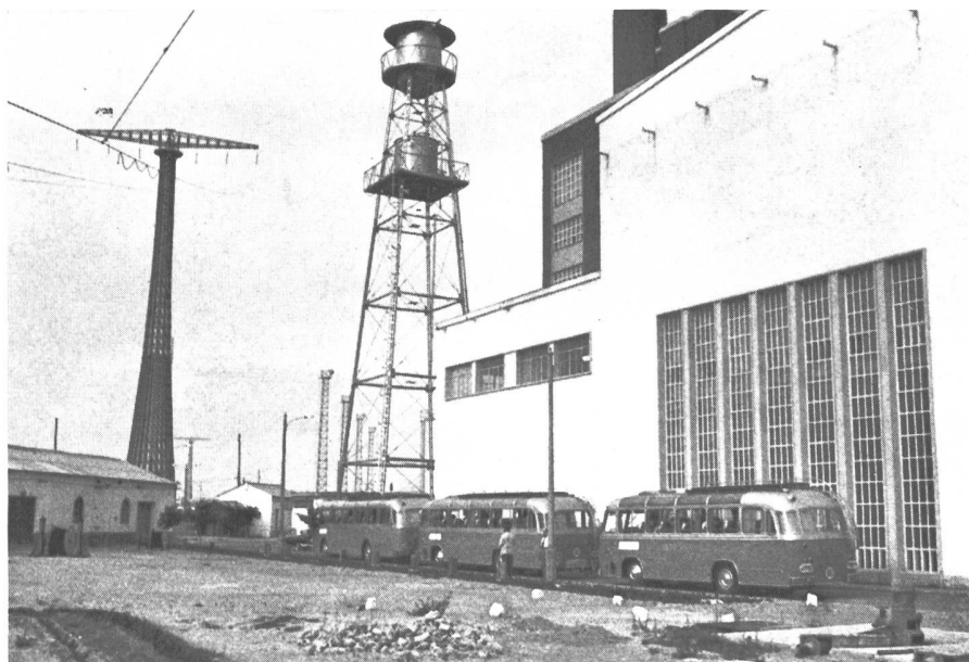
Bild 79 Thermische Zentrale der Stadt Cádiz in Südspanien, links südlicher Hauptmast für die 1640 m weit gespannte 138-kV-Leitung über die Meeresbucht von Cádiz. Im Vordergrund die drei Cars der Reisegruppe SO der WPC
