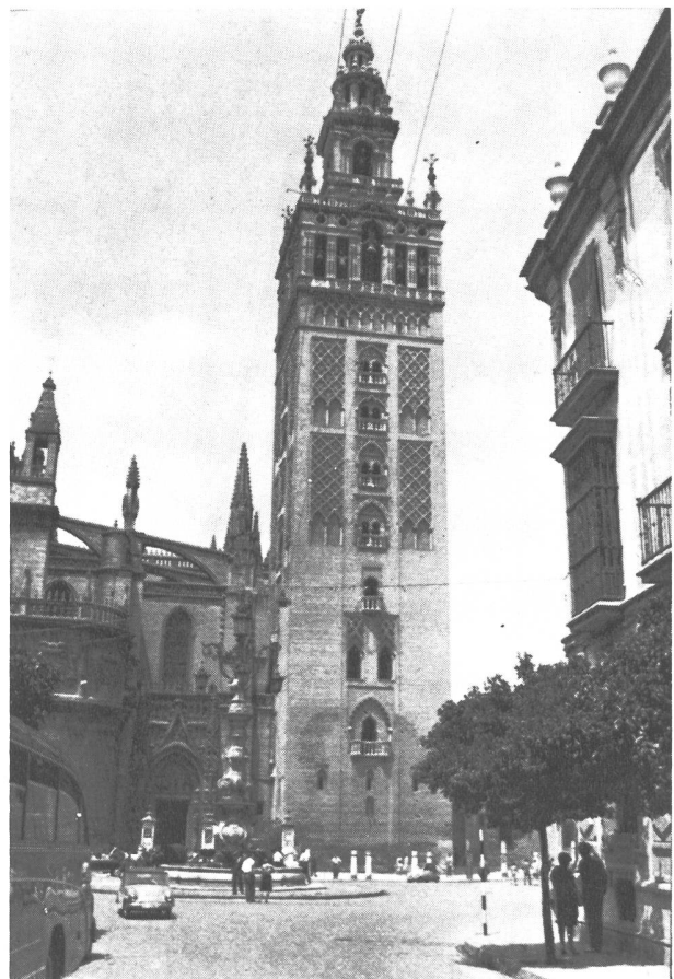
Bild 66 Die im 12. Jahrhundert errichtete «Giralda», das Wahrzeichen von Sevilla. Der aus maurischer Zeit stammende Turm diente als Minarett der Hauptmoschee; der Glockenturm mit Aufbau wurde einige Jahrhunderte später aufgesetzt
