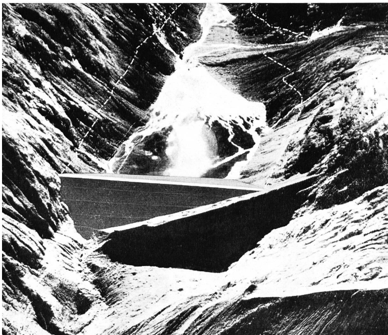
Bild 5 Flugaufnahme der Mattmarkebene, von Norden nach Süden gesehen, in welcher der zukünftige Staudamm von 115 m max. Höhe, 780 m Kronenlänge, 373 m größter Breite des Dammfußes und 10 Mio m 3 Volumen eingezeichnet ist, wie auch das Niveau der maximalen Staustauke auf 2197 m ü. M.
