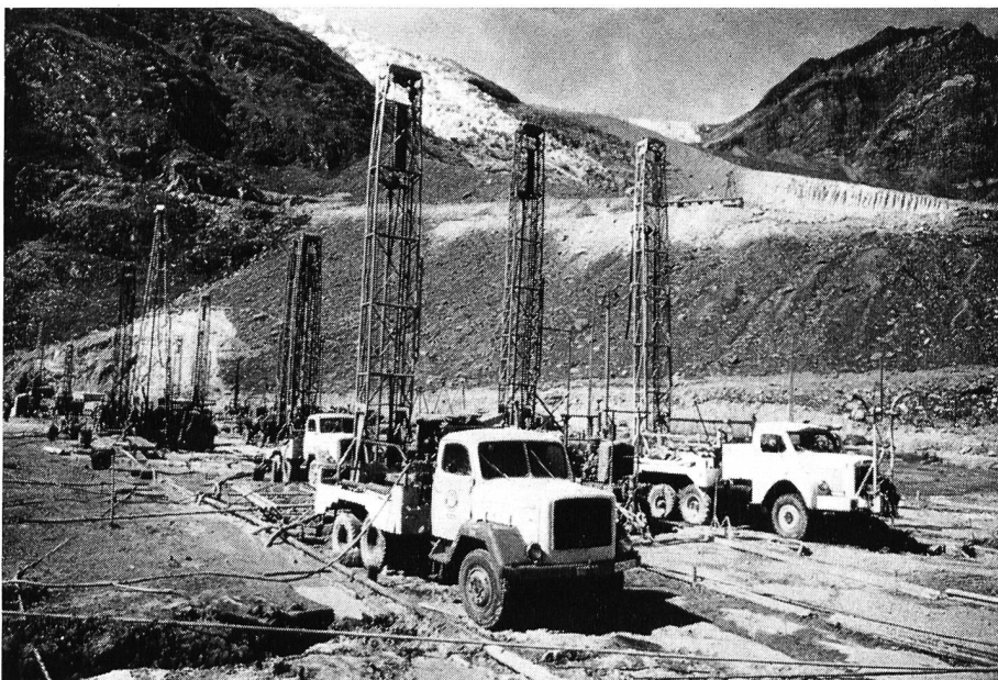
Bild 21 Bohrgeräte auf der Arbeitsplattform in Arbeit
