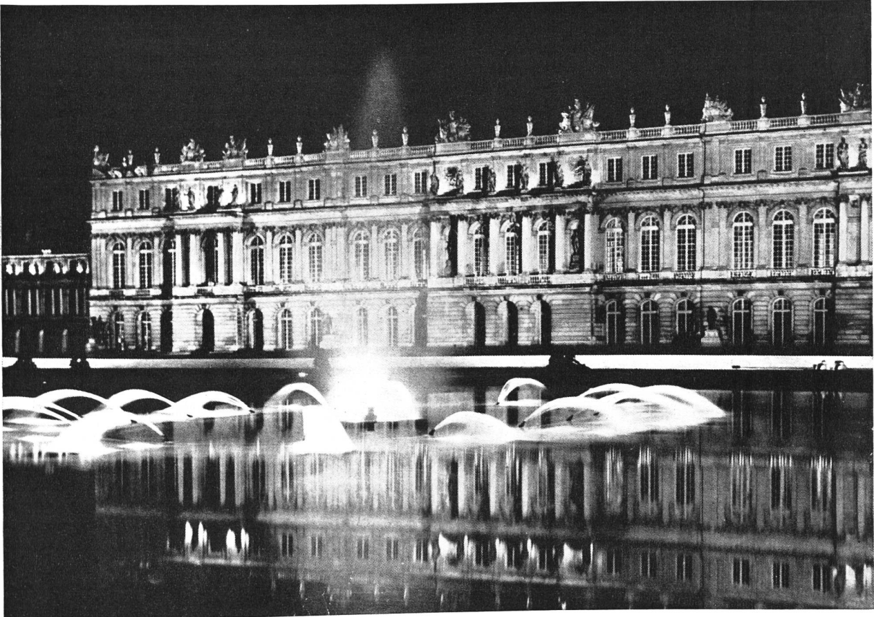
Bild 9 In nächtlicher Festbeleuchtung erstrahlende Hauptfassade des Schlosses Versailles während der Aufführung von «Son et lumière»
