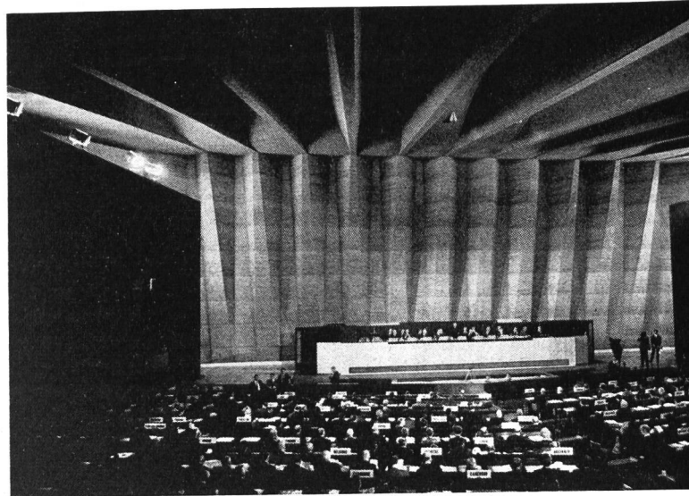
Bild 6 Der große, 1000 Personen fassende Konferenzsaal im UNESCO-Gebäude; man beachte die sehr originelle Behandlung der Betonwandflächen mit roher Schalungsstruktur
