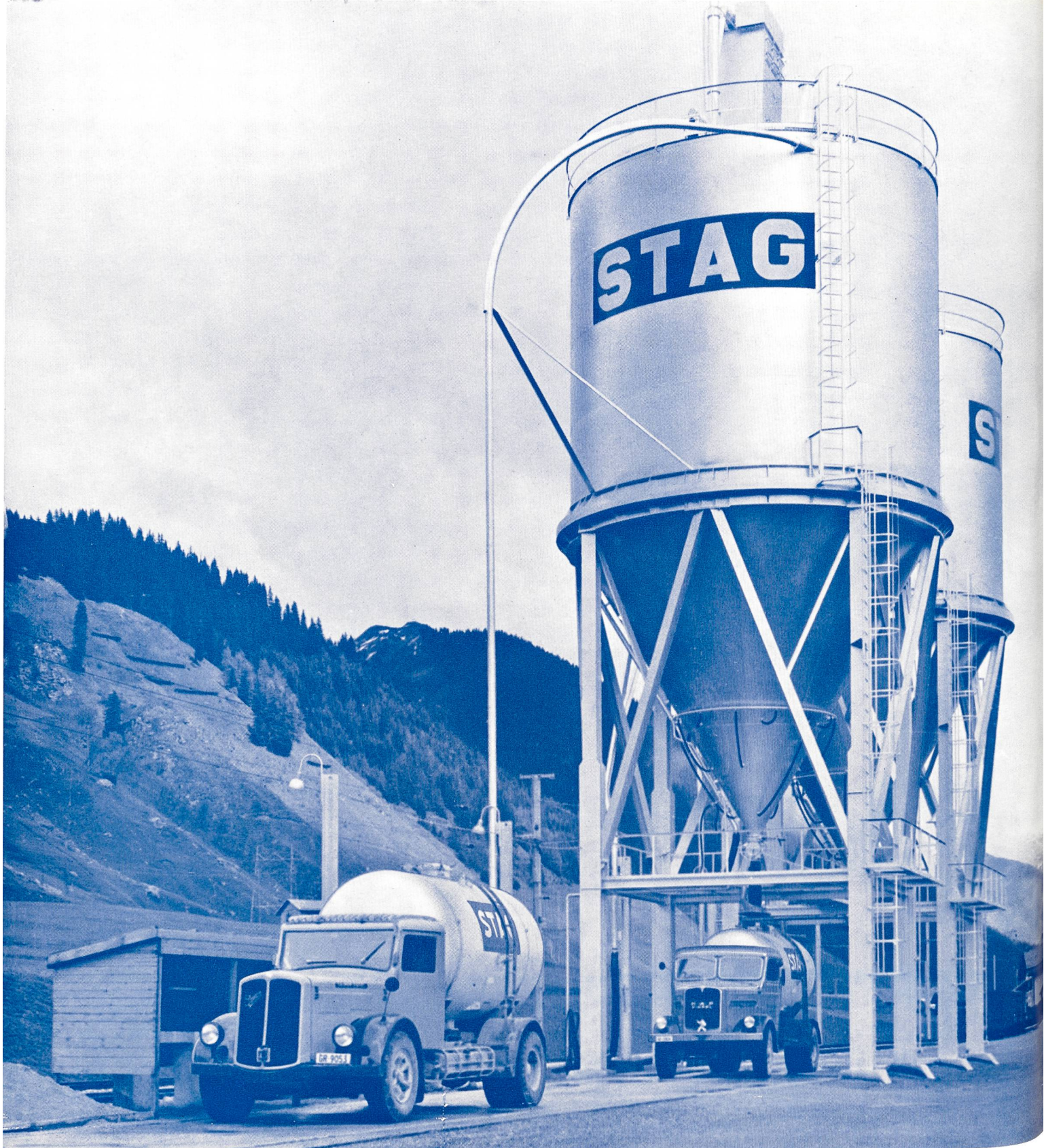
Umschlagsanlage der STAG in Sedrun: 2 Silos à 500 t = 1000 t Fassungsvermögen 2 Camions mit aufgebautem STAG-Behälter à 10 t 1 Brückenswaage 14 x 3 m mit 30 t Wiegefähigkeit
