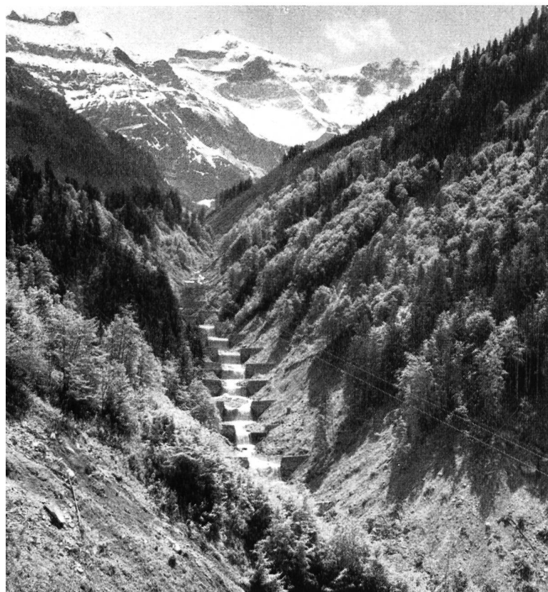
Bild 1 Wildbach-Verbauungen am Durnagelbach; Aufnahme Mai 1960
