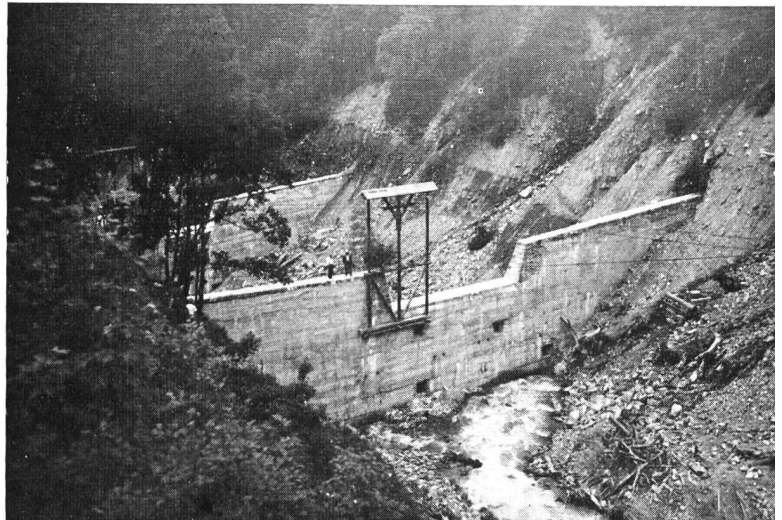
Bild 2 Noch nicht hinterfüllte Sperre im Durnagelbach, auf die eine Stütze der Bau-Seilbahn abgestellt ist; Aufnahme vom Juni 1960
