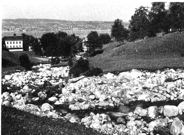
Bild 9 Ausbruch des Mühlebachs bei Richterswil im September 1934
