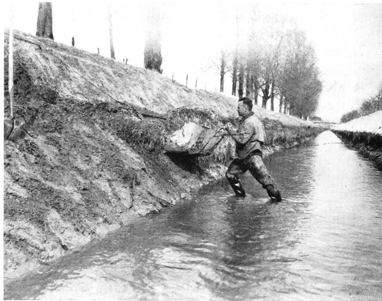
Bild 7 Abtrag verwachsener Böschungen mit Seilzug-Schleppschaufel im Rufibach
