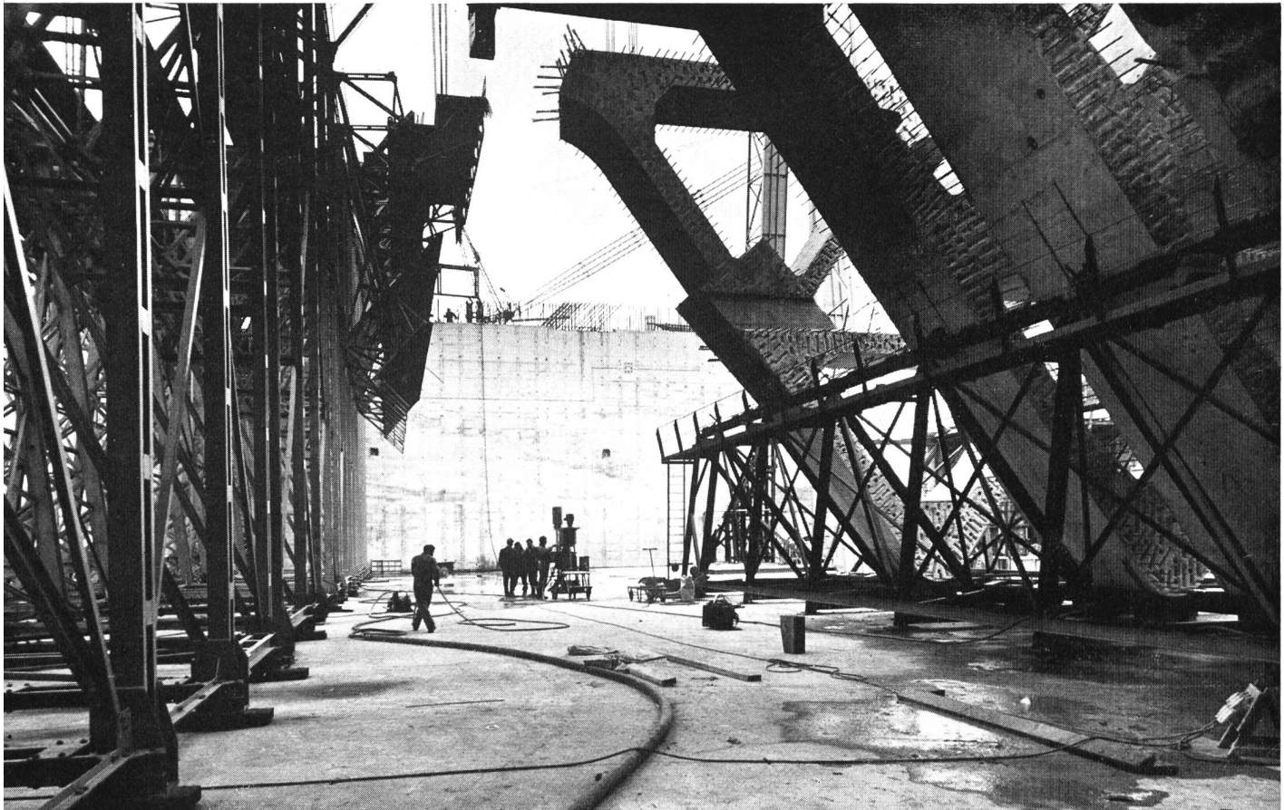
Bild 30 Auf der Baustelle Haringvliet; rechts einige der riesigen Eisenbeton-Dreiecksträger (siehe auch Bilder 31/34)
