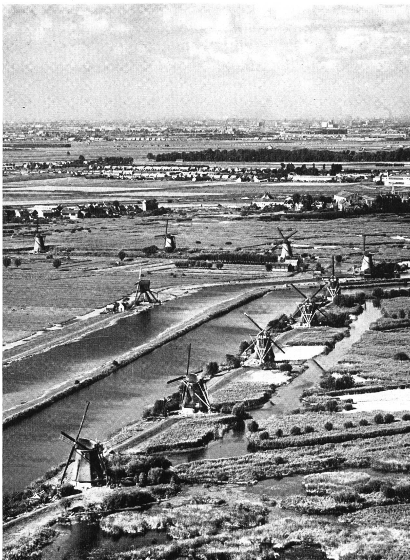
Bild 50 Übersicht über das Windmühlengebiet von Kinderdijk am Lek, einem Mündungsarm des Rheins
