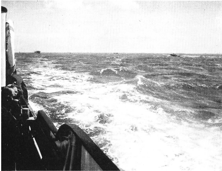
Bild 25 Meerfahrt von Hellevoetsluis zur Insel-Baustelle Haringvliet
