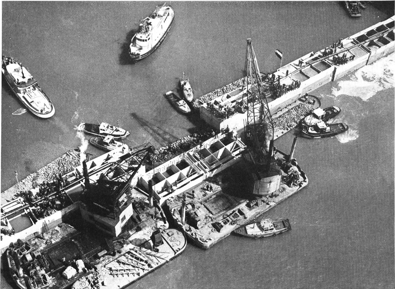
Bild 35 Schließung der letzten Dammlücke im Deltaarm der Zandkreek
