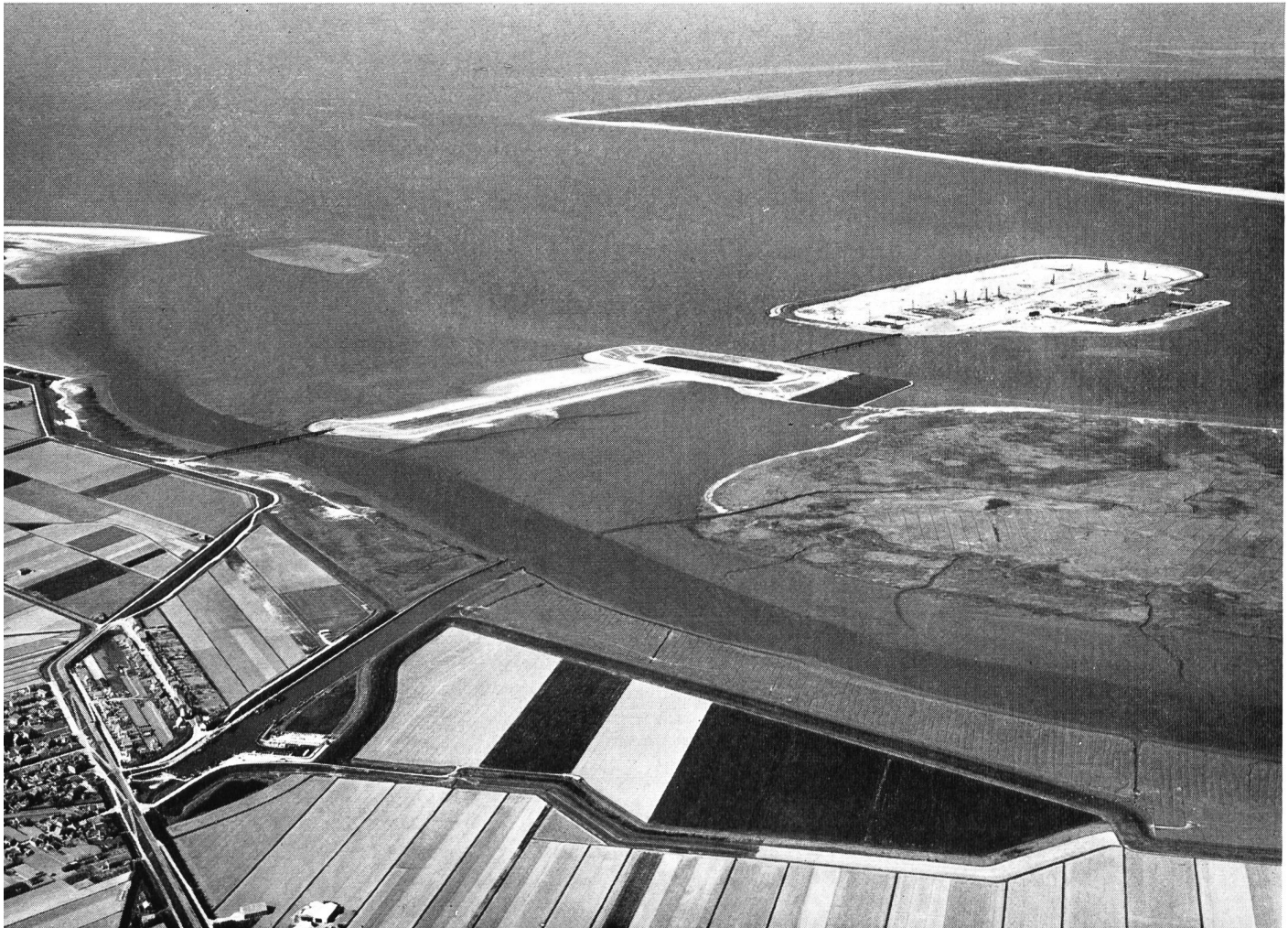
Bild 26 Luftaufnahme der im Meer geschaffenen Insel für die Baustelle Haringvliet mit eigener Hafenanlage (Aufnahme vom 21. April 1960)
