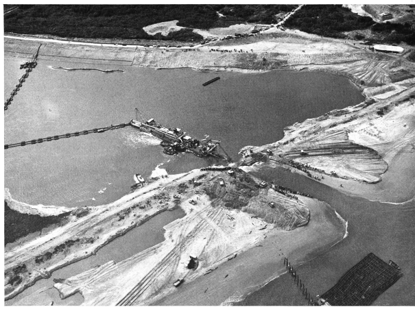
Bild 38 Umfangreiche Arbeiten zur Schaffung der neuen Hafenbecken von Europoort und zur Bereitstellung höher gelegener Landflächen für Lagergut und Industriebauten
