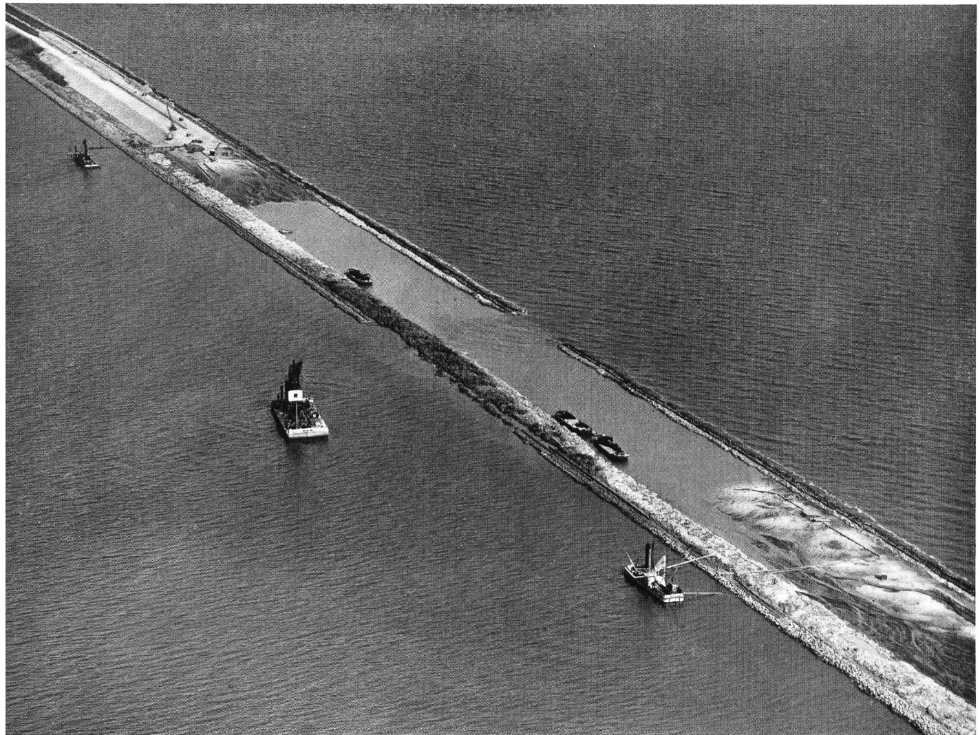
Bild 67 Deichbau in Ost-Flevoland (Zuiderseewerke)
