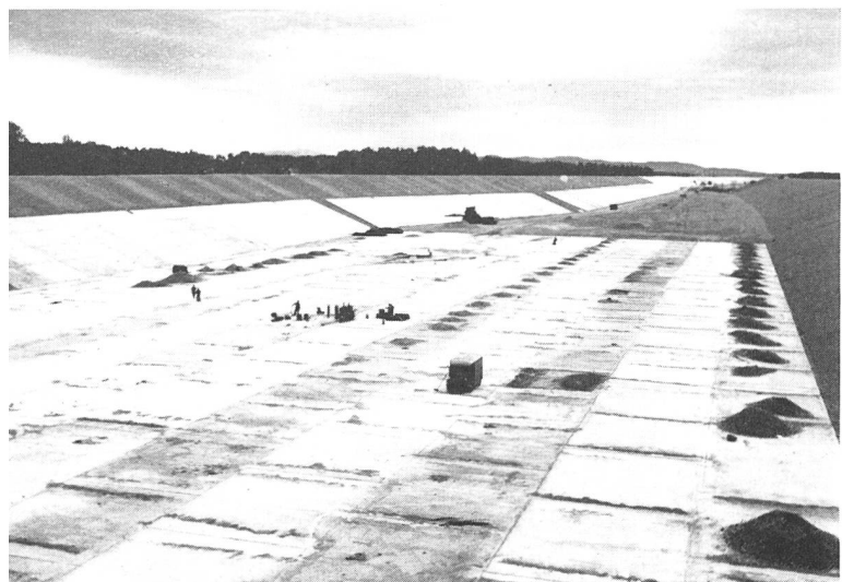
Bild 7 Schifffahrtskanal vor dem Schleusenbauwerk des Kraftwerks Rhinau
