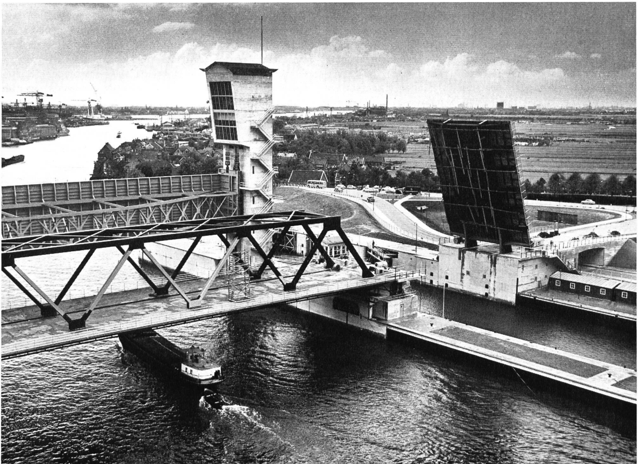
Bild 49 Sturmflutwehr Cappelle an der IJssel, ein zum Deltaplan gehörendes Bauwerk zum Schutz der tiefgelegenen und dicht bewohnten Gebiete östlich der Stadt Rotterdam Rechts für Holland typische Klappkonstruktion einer Brücke
