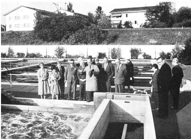
Erläuterungen bei der Gemeinschaftskläranlage von Künsnacht-Erlenbach
