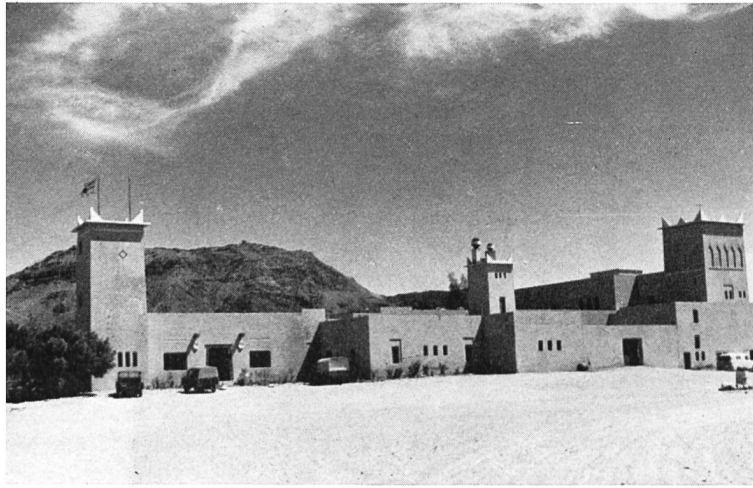
Fig. 126 Gîte d'étape; in traditioneller Architektur erbautes, sehr komfortables Hotel in der Oase Zagora am Draafluß, tief im Süden Marokkos
