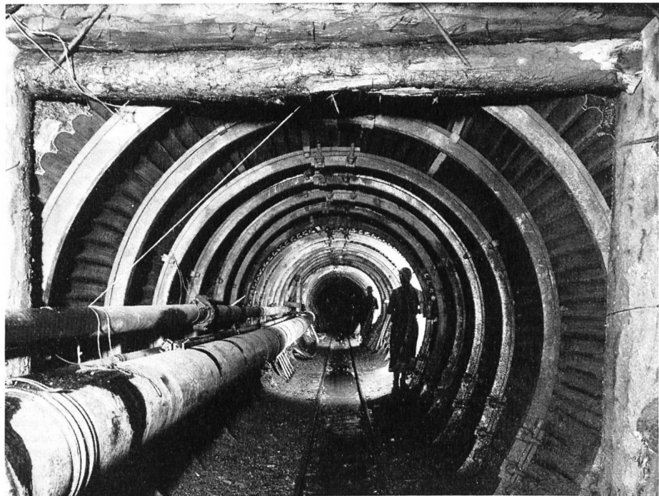
Fig. 11 Galerie d'amenée, entre les Charbonnières et le Fratzet.
