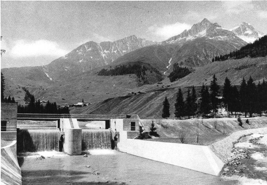
Fig. 8 Wasserfassung des Vorder- rheins in unmittelbarer Nähe der Kavernenzentrale Sedrun
