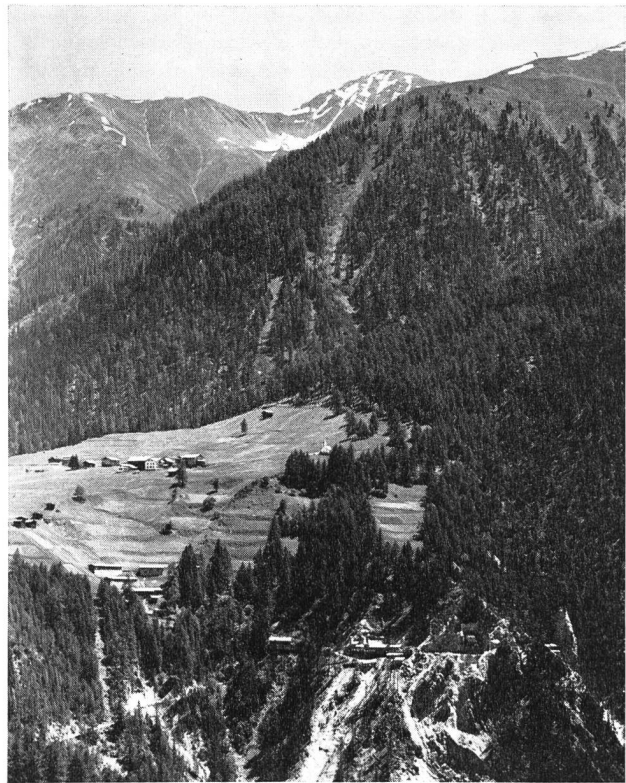
Fig. 9 Maiensäss Jenisberg und Baustelleninstallationen des Fensters Jenisberg
