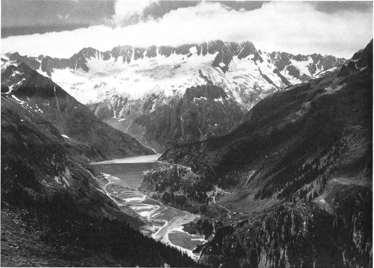
Fig. 2 Blick auf Staudamm und Stausee Göschenalp mit Dammagruppe im Hintergrund (Flugbild Swissair-Photo AG)
