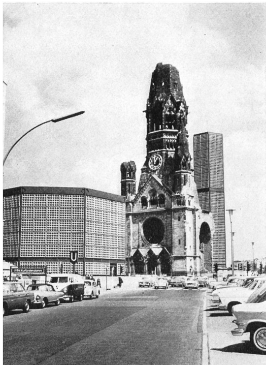
Fig. 10 Ruine der Gedächtniskirche mit moderner neuer Kirche und Glockenturm, von den Berlinern witzig «Puderdose» und «Lippenstift» genannt.
