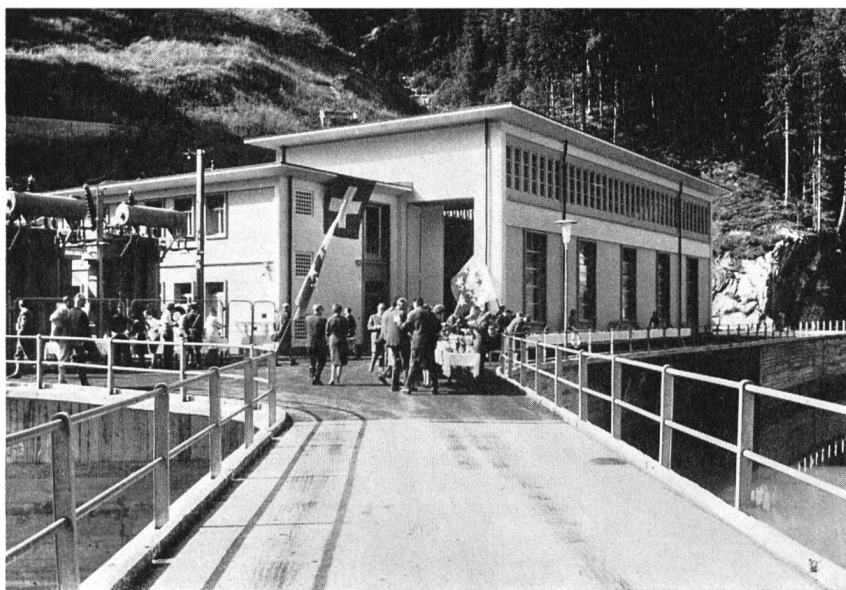
Fig. 11 Maschinenhaus der Kraftwerkstufe Les Toules-Pallazuit der Société des Forces Motrices du Grand St. Bernard. Projekt und Bauleitung der Anlagen waren der Suselectra Basel übertragen.
