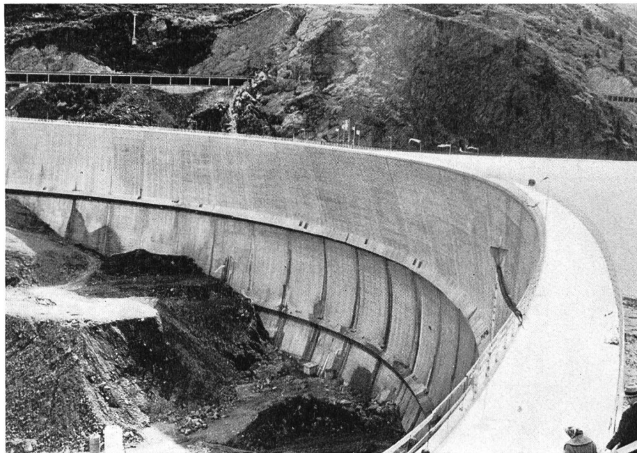
Fig. 10 Bogentalsperre Les Toules; im Hintergrund Galerien der Strasse über den Grossen St. Bernhard und zum neuen Strassentunnel.
