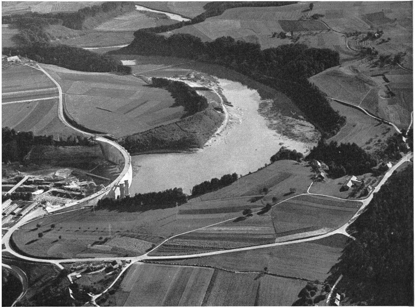
Fig. 18 Luftaufnahme der Talsperre Schifflenen der Entreprises Electriques Fribourgeoises an der Saane; das Maschinenhaus steht am linksseitigen Fuss der Bogenmauer, über deren 417 m lange Krone die neue Strasse führt; der zukünftige Stausee reicht auf seiner Länge von 13,5 km bis in die Gegend der Stadt Freiburg.
