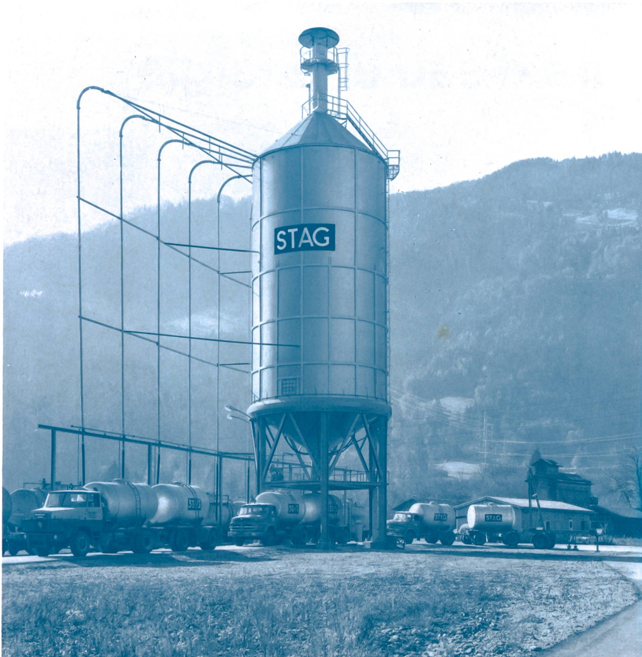
Umschlagsanlage der STAG in Vandans/Vlbg. mit Silo von 1600 t Fassungsvermögen. Zementtransporte nach der Baustelle der Staumauer Kops der Illwerke.
