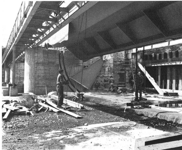
Fig. 1 Stauwehrsanie rung: Einbau von Segmentschützen
