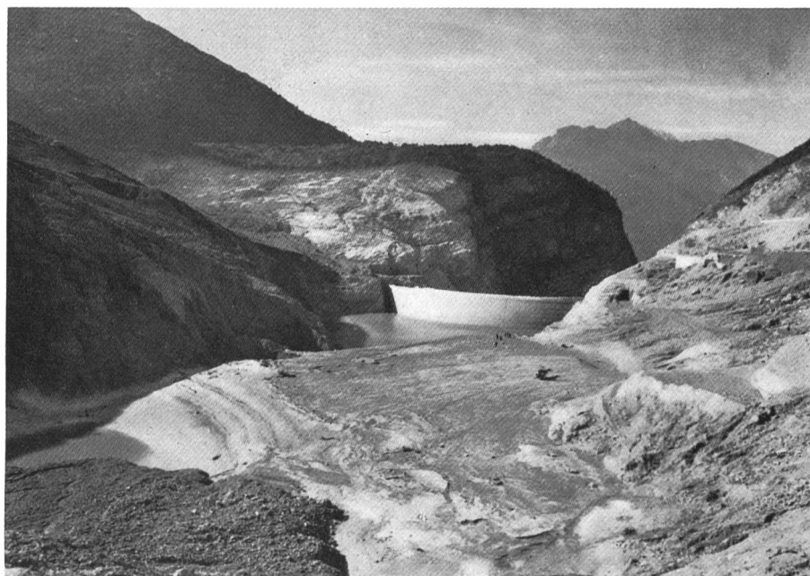
Fig. 20 Blick von der Rutschmasse im ehemaligen Stausee zur Bogenstaumauer: oberhalb des linken Widerlagers ist die ausgedehnte, von Wald entblösste, von der Flutwelle kahlgefegte Felsfläche gut sichtbar. Diese Vernichtung des Waldes reicht bis 120 m über Stauziel in 350 m horizontaler Entfernung.
