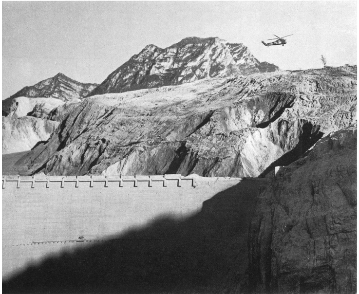
Fig. 9 (unten) Linke Flanke der Staumauerkrone von unterwasserseits gesehen; in Bildmitte die gewaltigen Rutschmassen. Man beachte besonders die grossen Trichter in der Rutschmasse, die wohl durch das Zurückfluten der Wassermassen entstanden sind (siehe auch Fig. 10, 12, 19).
