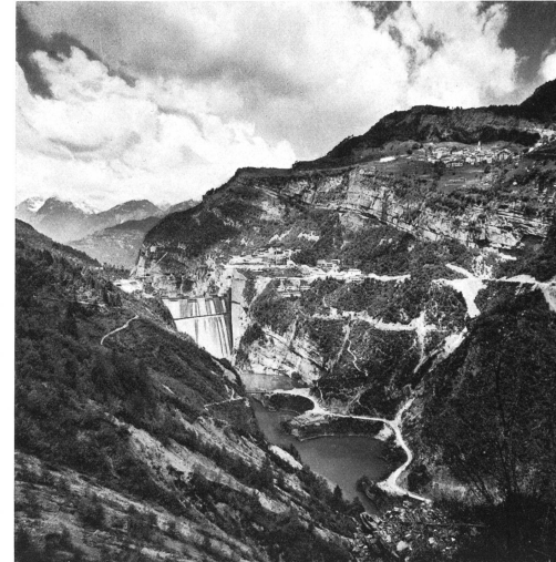
Fig. 7 Uebersicht über das Staubecken Vaiont, talwärts gesehen, während der letzten Bauphase. Auf der rechten Talseite erkennt man die Bauinstallationen; am oberen Bildrand das Dorf Casso, bis zu dessen ersten Häusern die Flutwelle hinaufgebrandet ist!
