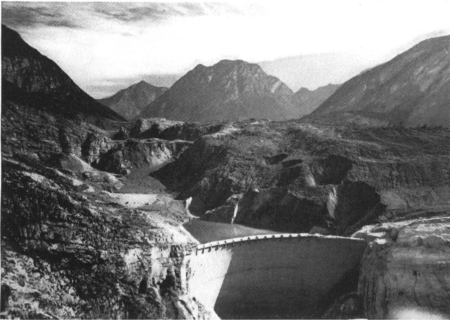
Fig. 19 Staumauer Vaiont und Blick in Richtung des ehemaligen grossen Speichersees; die abgerutschten Fels- und Erdmassen überragen bei weitem die Staumauerkrone und werden im ersten Expertenbericht auf etwa 300 Millionen Kubikmeter geschätzt.
