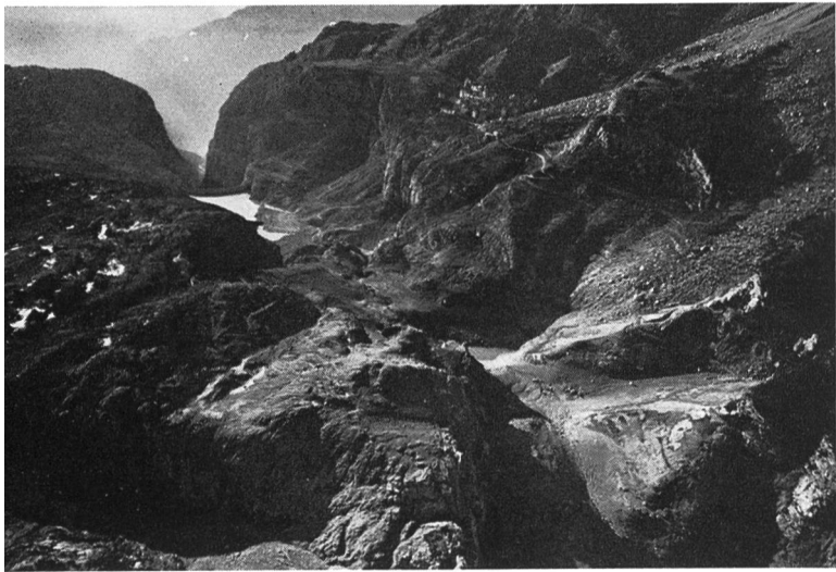
Fig. 22 Ueberblick über die gewaltigen Massen, die den Stausee ausgefüllt haben (vgl. Fig. 8). Man beachte das 200 m über Stauziel am rechten Talhang gelegene Dorf Casso.
