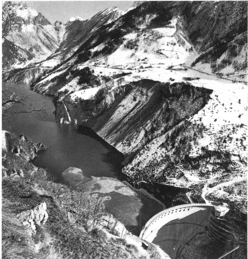
Fig. 6 Uebersicht über Staubecken und Talsperre Vaiont im Spätherbst 1960, nach dem ersten Rutsch auf der linken Talseite.
