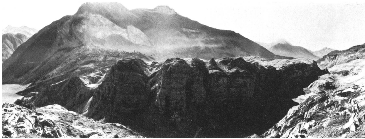
Fig. 8 (oben) Aufnahme nach der Katastrophe, vom rechten Seeufer aus. Die im Vordergrund sichtbaren grossen Felsmassen stellen die abschliessende Front der abgerutschten Massen dar, mit der Abrisslinie im Hintergrund. Rechts hinten liegt die Staumauer, links der abgetrennte hintere Teil des Stausees.
