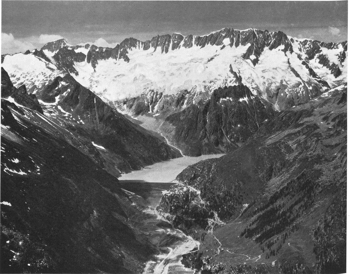
Staudamm und Stausee Göscheneralp des Kraftwerks Göschenen
