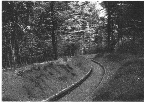
Fig. 1 Sickergraben zur Anreicherung des Grundwassers (Brodbeck)
