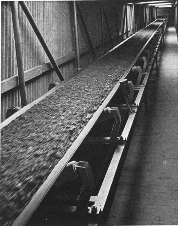
ICO-CUSHION-Transportband in einem Kieswerk
