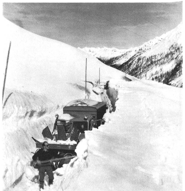
Fig. 7 Öffnen der Zufahrtstrasse zur Baustelle Cruina (Val Bedretto) im April 1964
