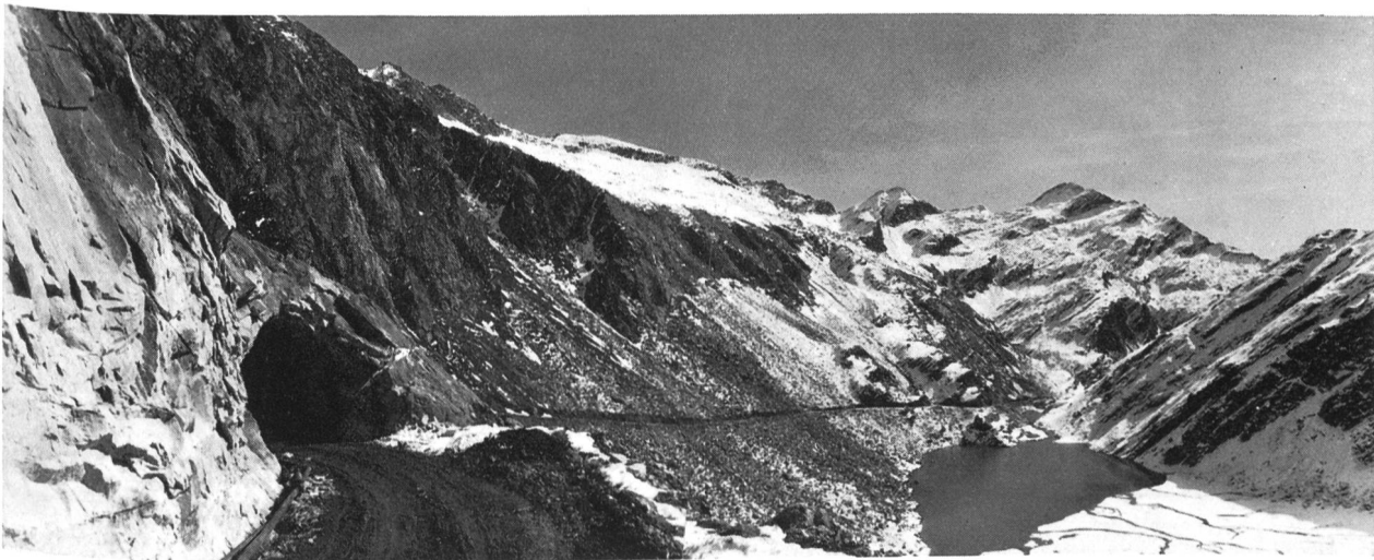
Fig. 1 Zufahrtsstrasse Robiei-Cavagnoli, Passage längs des Lago Bianco; Bauzustand Oktober 1963
