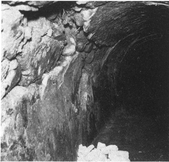
Der Stollen vor der Behandlung mit «Cital-Aquapaint» (Bild 2 Detail-Ansicht)
