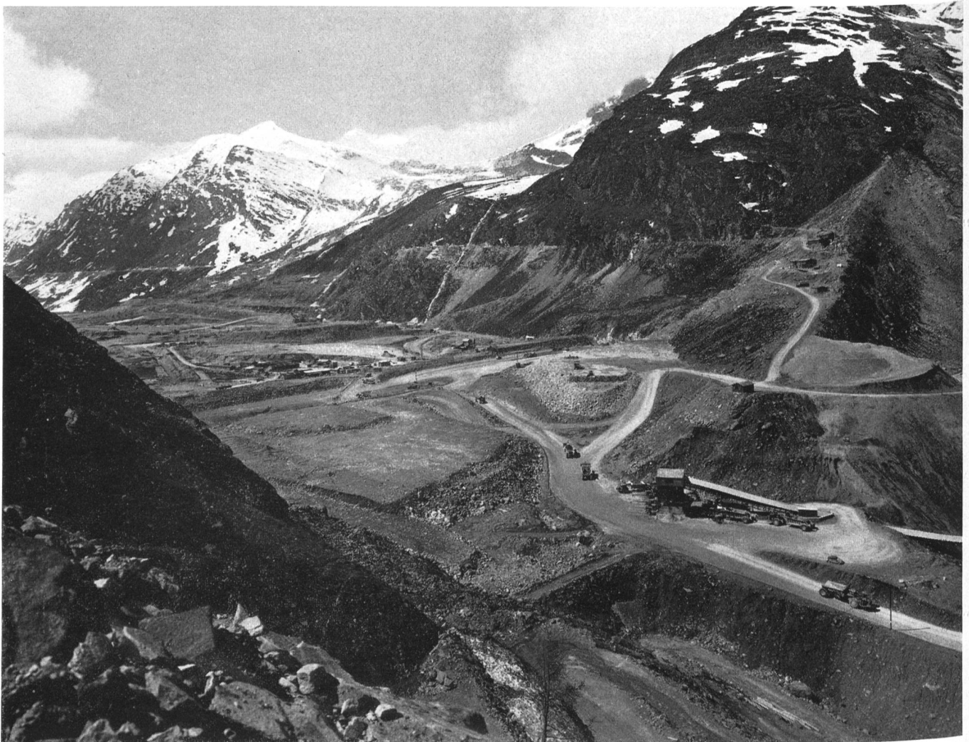
Dammbaustelle und Staugebiet Mattmark, Juni 1964
