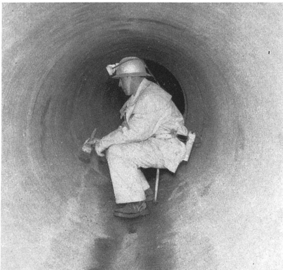
Beschichteter Stollenabschnitt nach dem Auskleiden mit «Cital-Aquapaint»
