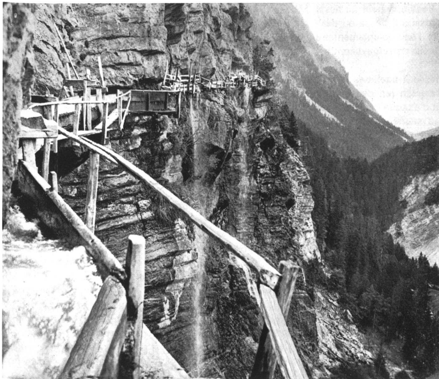
Fig. 4 Bisse suspendu, avec passerelle et chéneau, pour gros débit. Le bisse du Torrent-Neuf, à Savièse, accroché depuis le 16e siècle à la paroi des Branlires.
