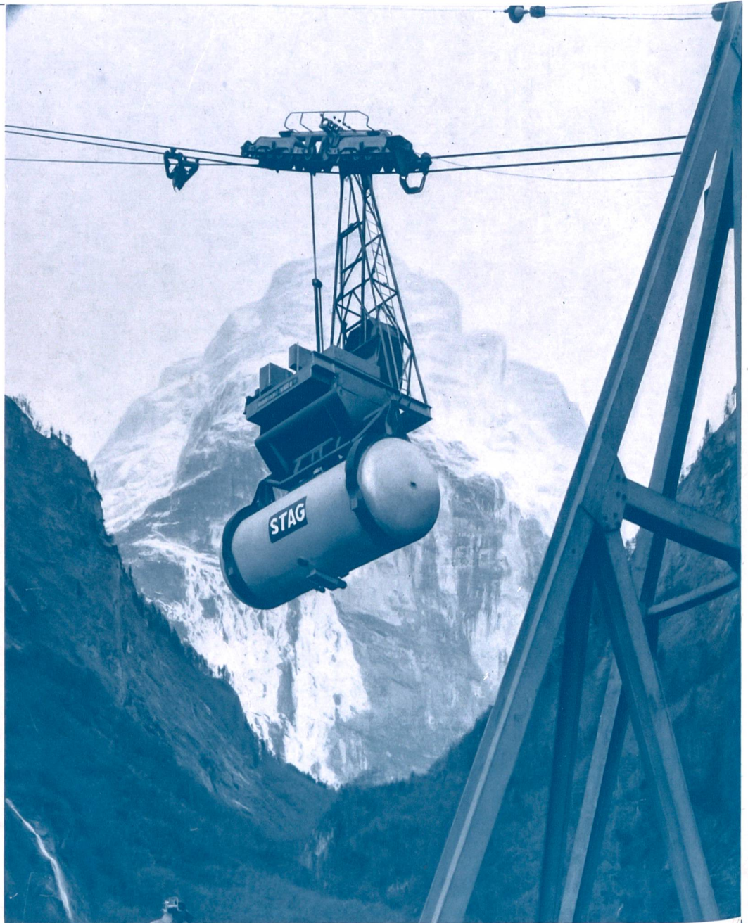
Aluminium-Behälter STAG an der Schwereiseilbahn der KW Linth-Limmern, Fassungsvermögen 16 t Zement
