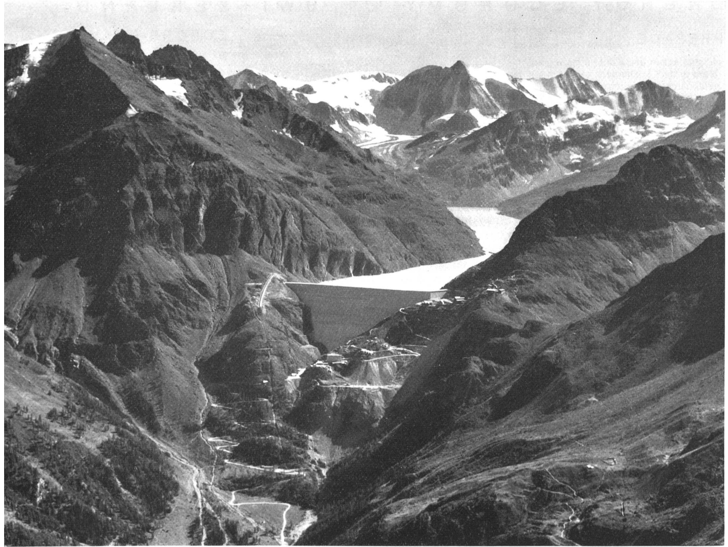
Staumauer und Stausee Grande Dixence im Val des Dix, Kanton Wallis Barrage de la Grande Dixence et lac du Val des Dix, Valais Grande-Dixence Dam with reservoir-lake in Val des Dix, Valais
