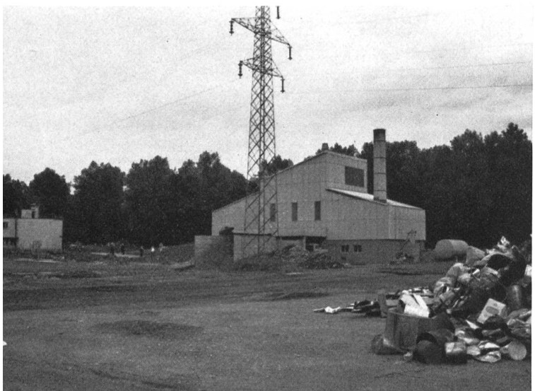
Fig. 9 Kehrichtverbrennungs- und -verwertungsanlage Werdenberg-Liechtenstein
