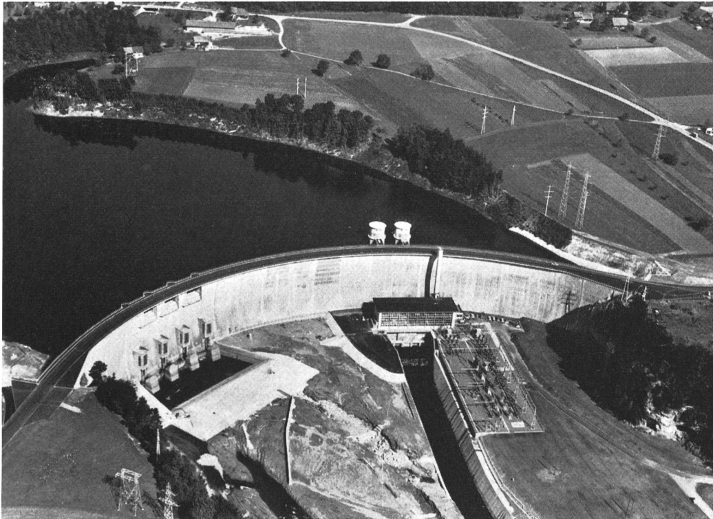
Staumauer und Stausee Schiffenen an der Saane; Kraftwerk und Schaltanlage am Fuss der Talsperre (Photo J. Mülhauser Fribourg)
