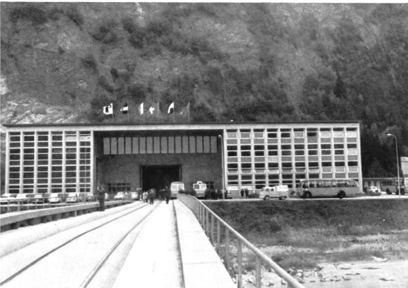
Bild 20 Monumentaler Eingang zur Kavernenzentrale Nendaz, der Unterstufe der Kraftwerkgruppe Grande Dixence.
