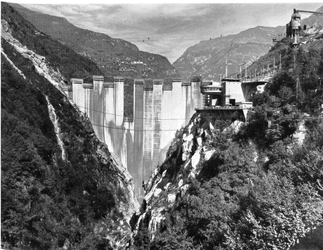
Bild 30 Talseitige Ansicht der 220 m hohen Bogenstaumauer Vogorno im untern Verzascatal. Rechts im Bild Eingangsbauwerk zum Lift und Vertikalschacht, der zur tiefgelegenen Kavernenzentrale führt.
