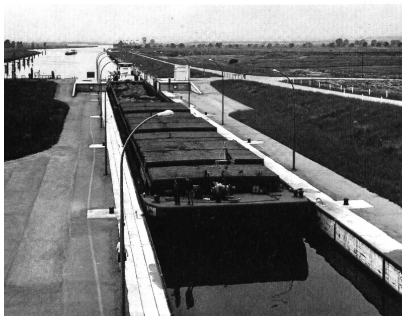
Fig. 8 (en haut) Le convoi du «Metz» entre dans l'écluse de Koenigsmaker. La marge de chaque côté entre les bajoyers de l'écluse et le convoi ne dépasse pas 0,30 m.
