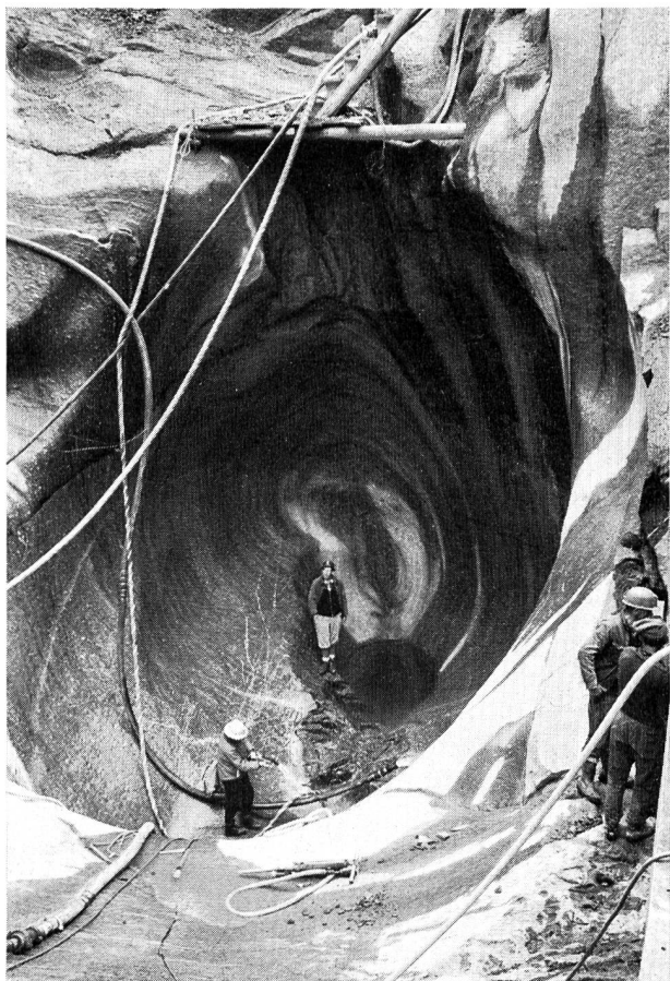
Bild 3 Detailaufnahme der grossen Gletschermühle mit einer Höhe von 8—10 m und einer Breite von 6—8 m im Betonierblock 10 der Staumauer Curnera.
