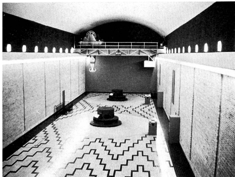
Bild 26 Blick in die moderne Kavernenzentrale Svaelgfoss der Norsk Hydro.
