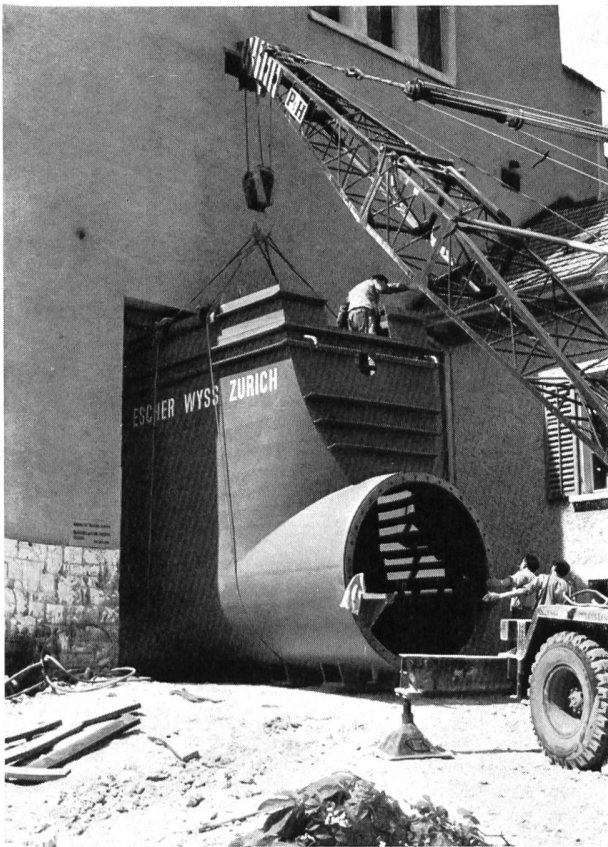
Bild 5 Antransport des Stahlgehäuses für eine Rohrturbine.
