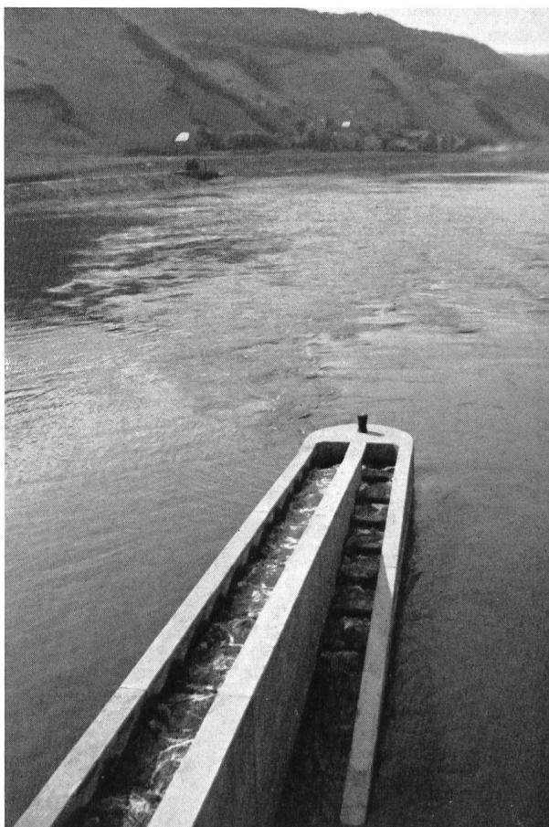
Bild 5 Fischtrappe beim Moselkraftwerk Enkirch.
