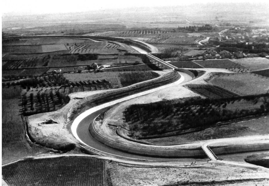
Vue aérienne du Canal principal — (tronçon Station A. DUMONT — Saint-Gilles). Au second plan, le pont-canal traversant la route Saint-Gilles — Nîmes
