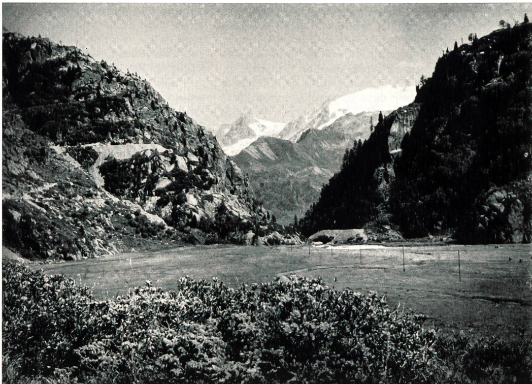
Fig. 3 Vue du site du barrage et du verrou rocheux depuis la cuvette d'Emosson
