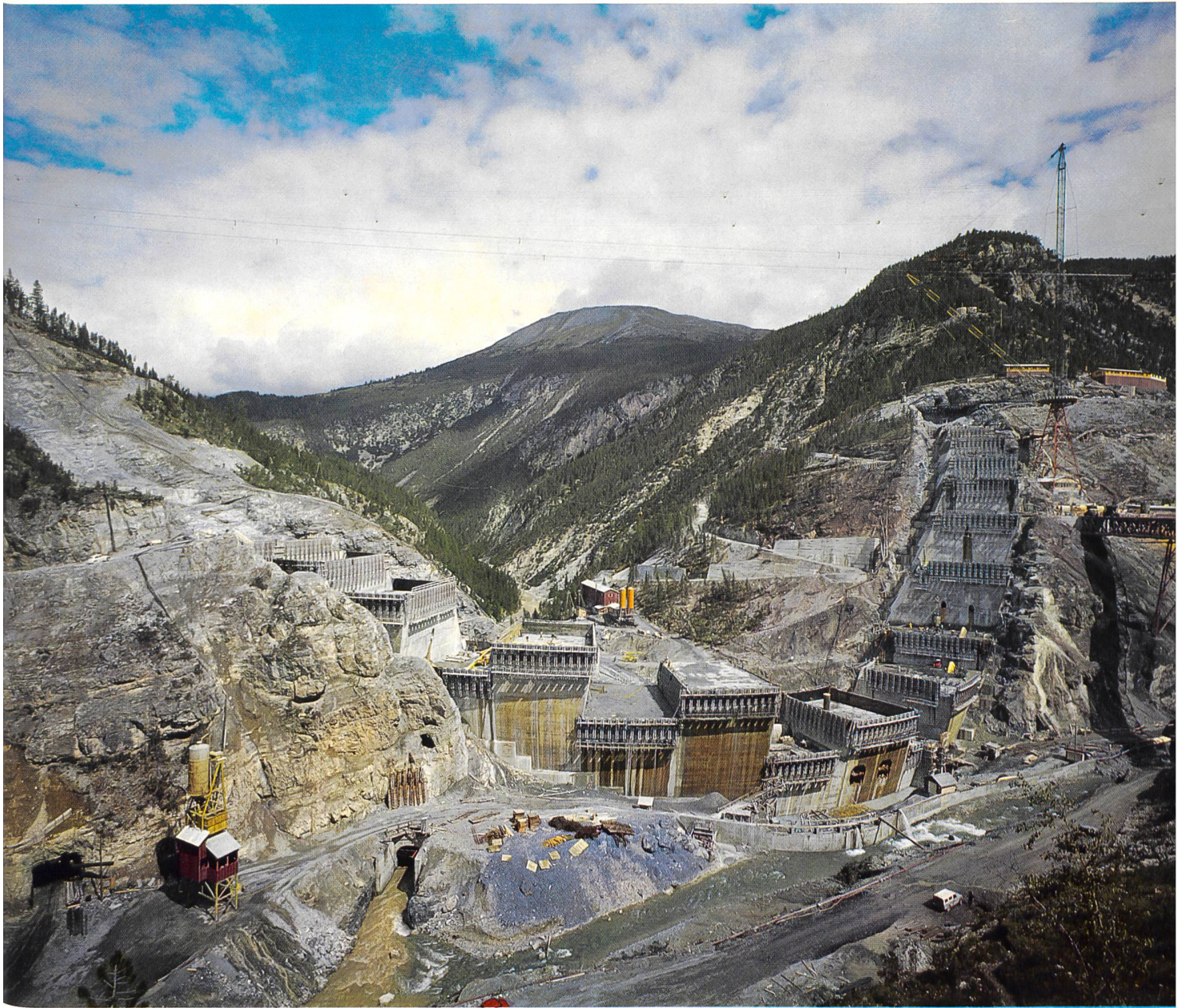
ENGADINER KRAFTWERKE: Staumauer Punt dal Gall. Die Ansicht von der Wasserseite zeigt den Stand der Arbeiten Mitte Juli 1966. Im Vordergrund, von links nach rechts, der Druckstolleneingang, der Umleitstollen und der durch das Mauerfundament führende Grundablass. In der Bildmitte die Injektionszentrale für die Ausführung des Dichtungsschleiers. Im Hintergrund der Munt la Schera. (Foto Feuerstein, Scuol/Schuls)
