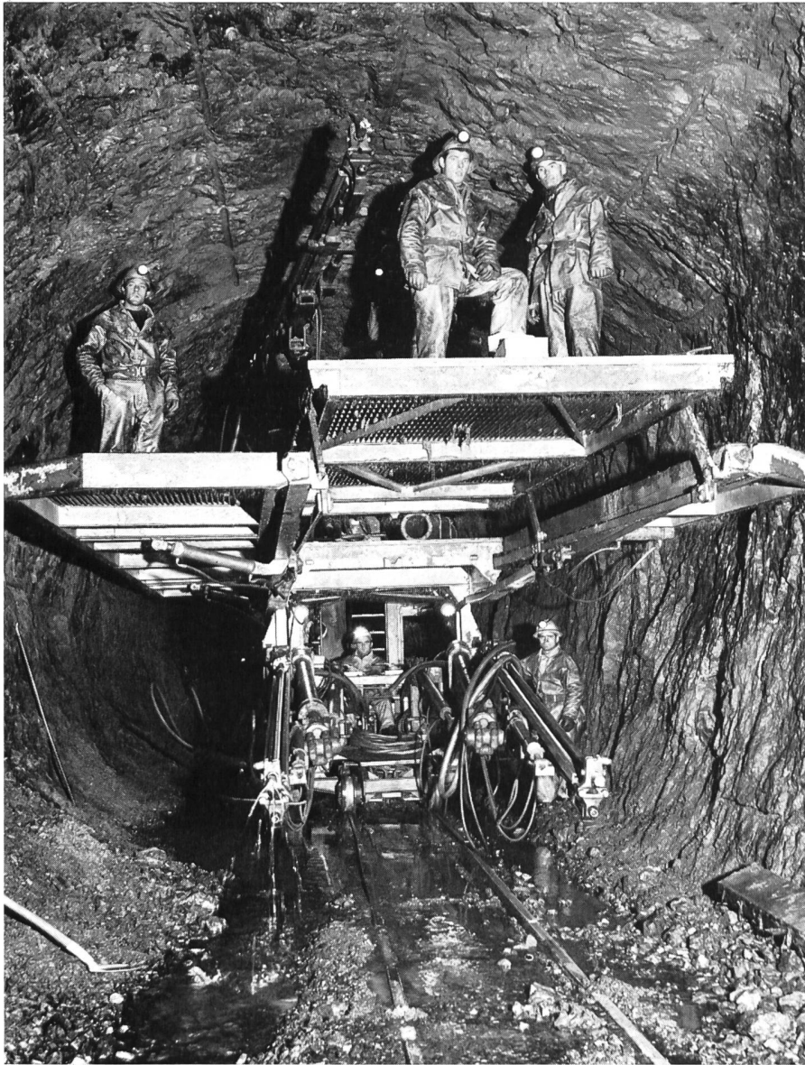
Bild 65 Bohrwagen in einem der Druckstollen
