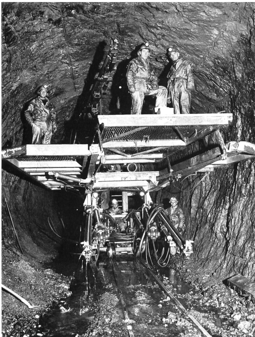
Bild 65 Bohrwagen in einem der Druckstollen
