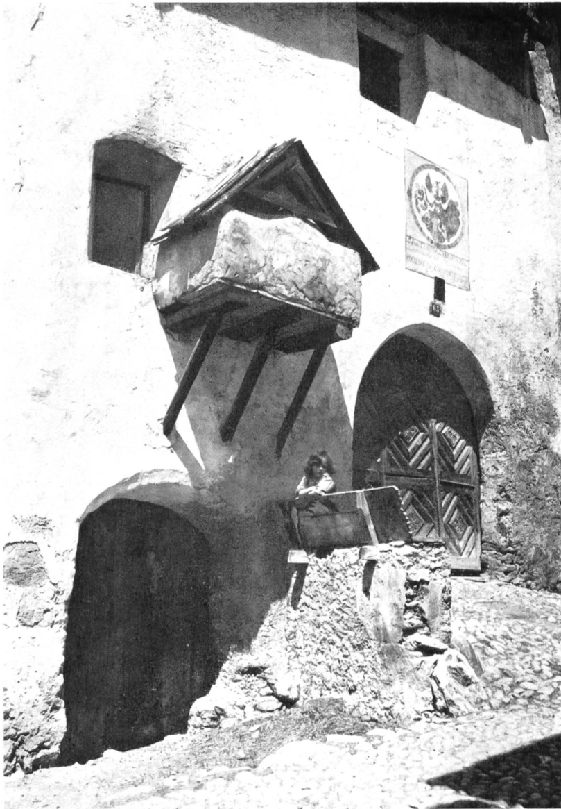
Bild 100 Bei alten Engadinerhäusern im Unterengadin — hier handelt es sich um ein Haus in Scuol/Schuls — ist noch da und dort der Brotbackofen sichtbar, dessen Ausbuchtung deutlich die Hausfassade durchbricht
